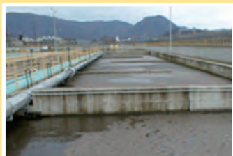
Vasche di decantazione
