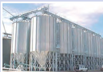
Batteria di silos
