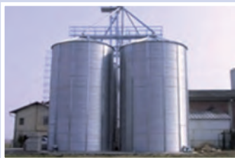
Silos per cereali
