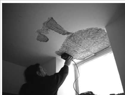
a) Esecuzione indagine magnetometrica all'intradosso di un solaio
