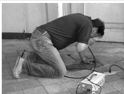
b) Esecuzione di tomografia endoscopica su solaio
