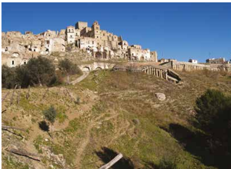
Figura 5.1 – Frana attuale composta che si è sviluppata nel 1972 sul versante meridionale della collina di Craco, provincia di Matera, Appennino Meridionale. Il paese, di origine medievale, era posizionato su una placca arenacea sovrastante argille grigie del Pliocene medio-superiore
