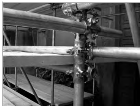
Figura 5.3 Giunti ortogonali in un ponteggio con sistema a tubi e giunti (Fonte: ABC del ponteggiatore, EPC Editore)
