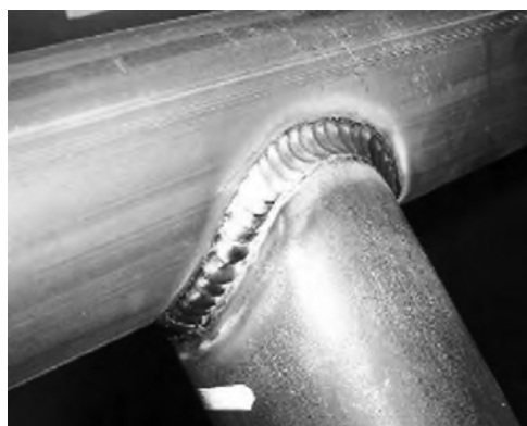
Figura 1.1 – Cordone di saldatura su profilo tubolare
