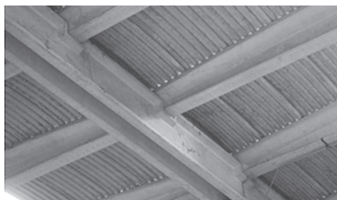
C – Copertura in eternit® (cemento - amianto) di un capannone industriale
