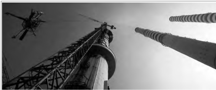
► Figura 1.25 Flying demolition: la macchina è portata in quota tramite gru (Despe)
