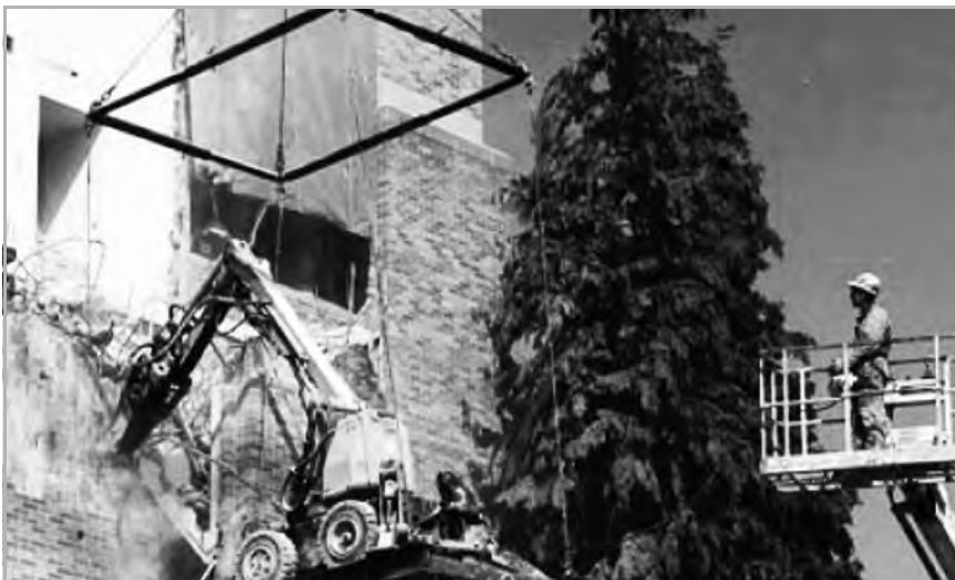
▲ Figura 1.22 Macchina radiocomandata al lavoro (Brokk)
