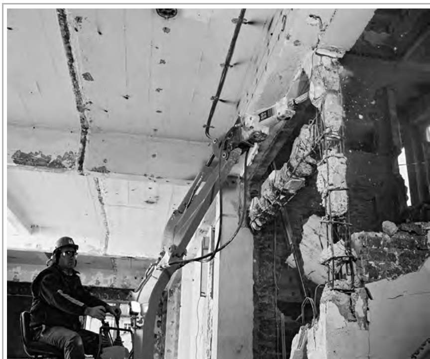
Figura 1.9 Mini escavatore con martello demolitore
