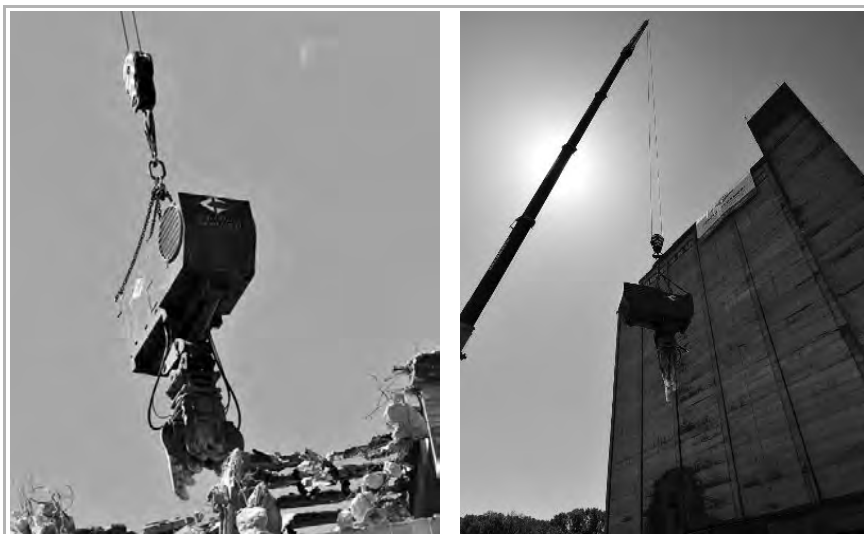
► Figura 1.26 Flying demolition dettaglio dell'attrezzo sospeso la gru stessa (General Smontaggi)
