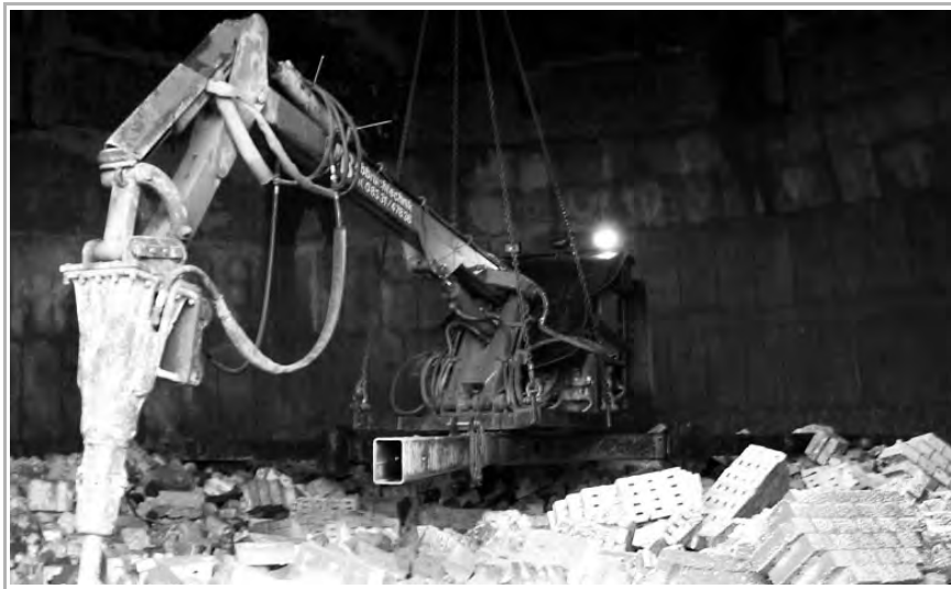
► Figura 1.24 Escavatore con martello sospeso ad una gru
