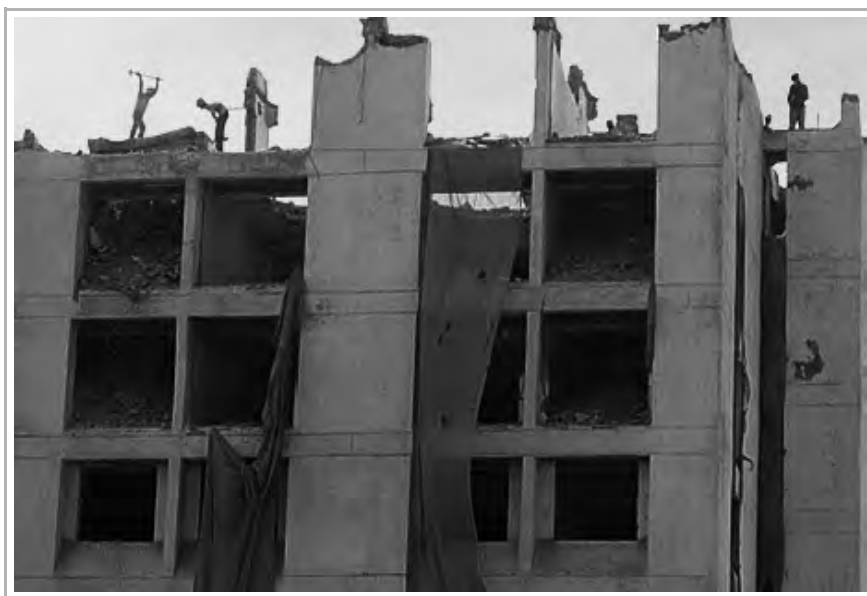
Figura 1.3 Fasi di una demolizione manuale (India)
