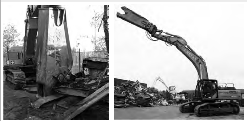
► Figura 1.11 A sinistra Cesoia al lavoro a destra Macchina con cesoia per struttura metallica
