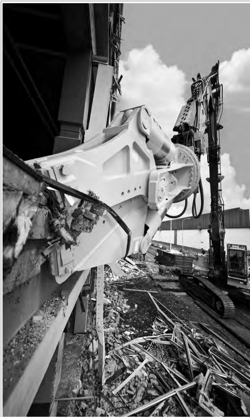
► Figura 1.20 Frantumatore mobile su braccio alto
